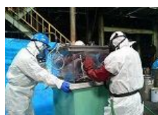
有害物質回収作業
